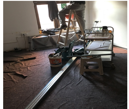
Der Umbau ist im vollen Gange
