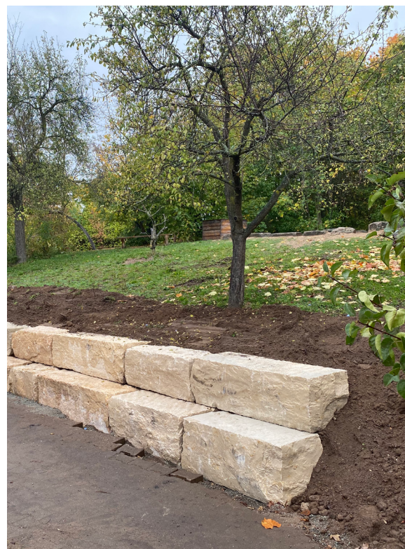
Die neue Stützmauer im Kita Garten
